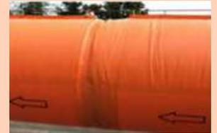
5. Los conductos deben mantenerse a una distancia de más de 10 cm de la pared de la galería para evitar rotura de objetos afilados y ásperos.
